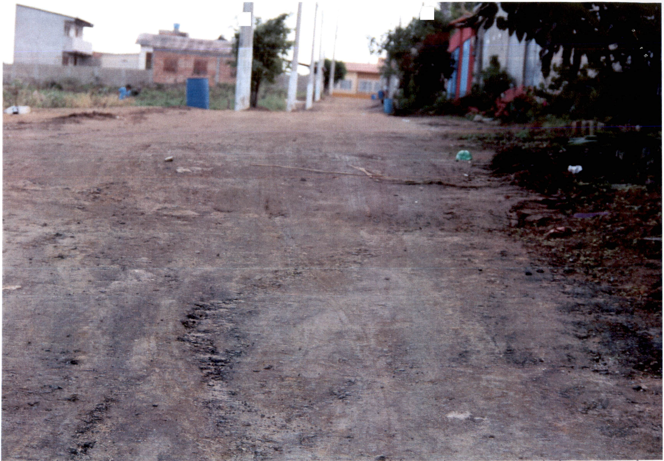
A mesma Rua das Tanqueiras em sentido contrário, começando da rua Coxixaba.
