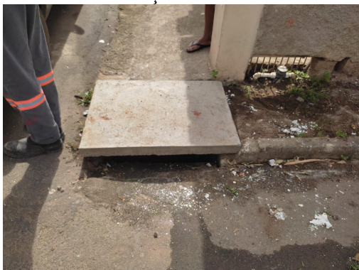
Foto de identificação bueiro II.
