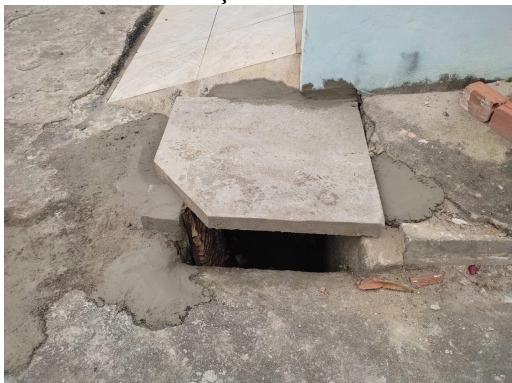
Foto de identificação bueiro II.
