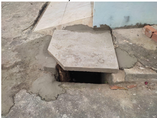
Foto de identificação bueiro II.
