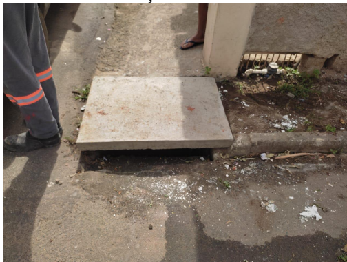
Foto de identificação bueiro II.
