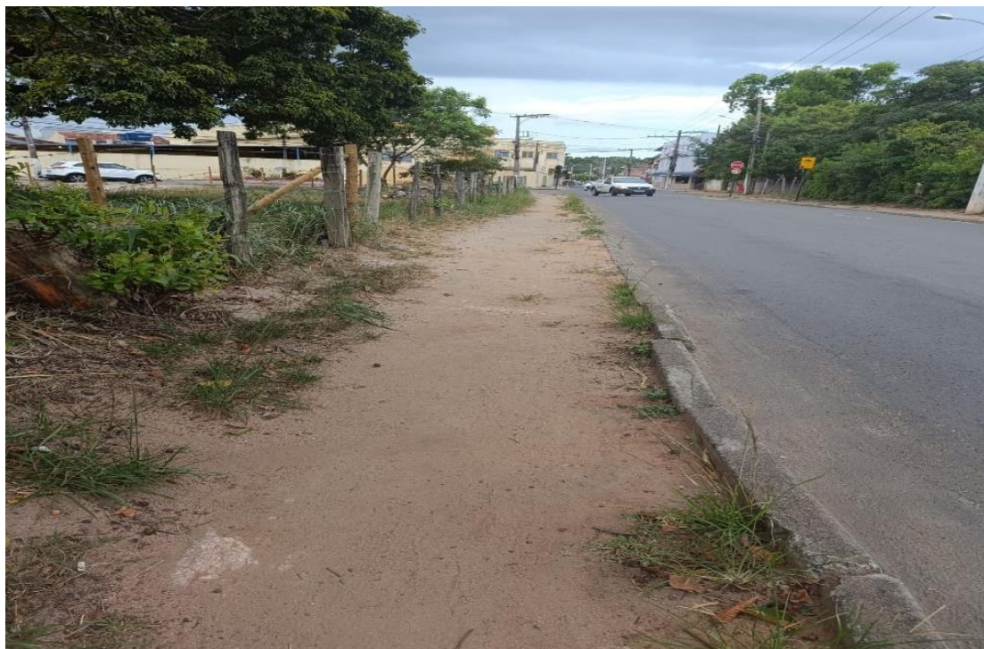
Rua Praia dos Castelhanos, localizada na Av. Rauta em frente à Escola Amarílis Fernandes Garcia
