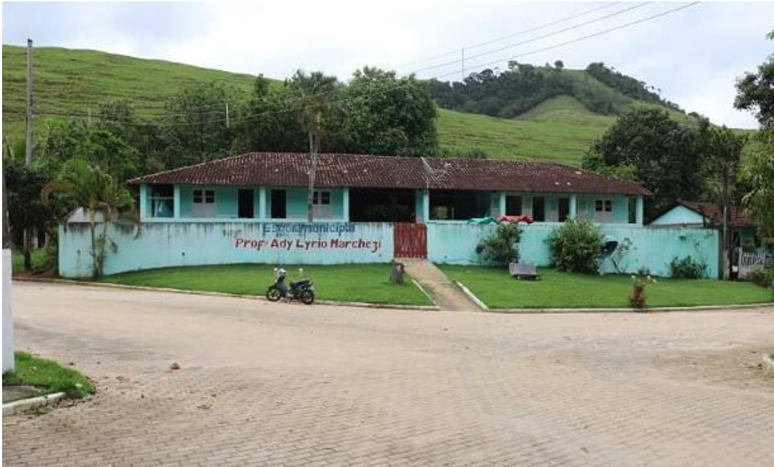
Melhorias na Escola Municipal como pintura, reforma de telhado dentre outros.
