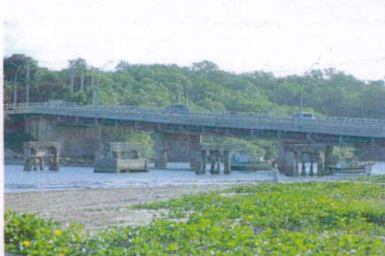
Figura 16 - Pilares da Antiga Ponte
